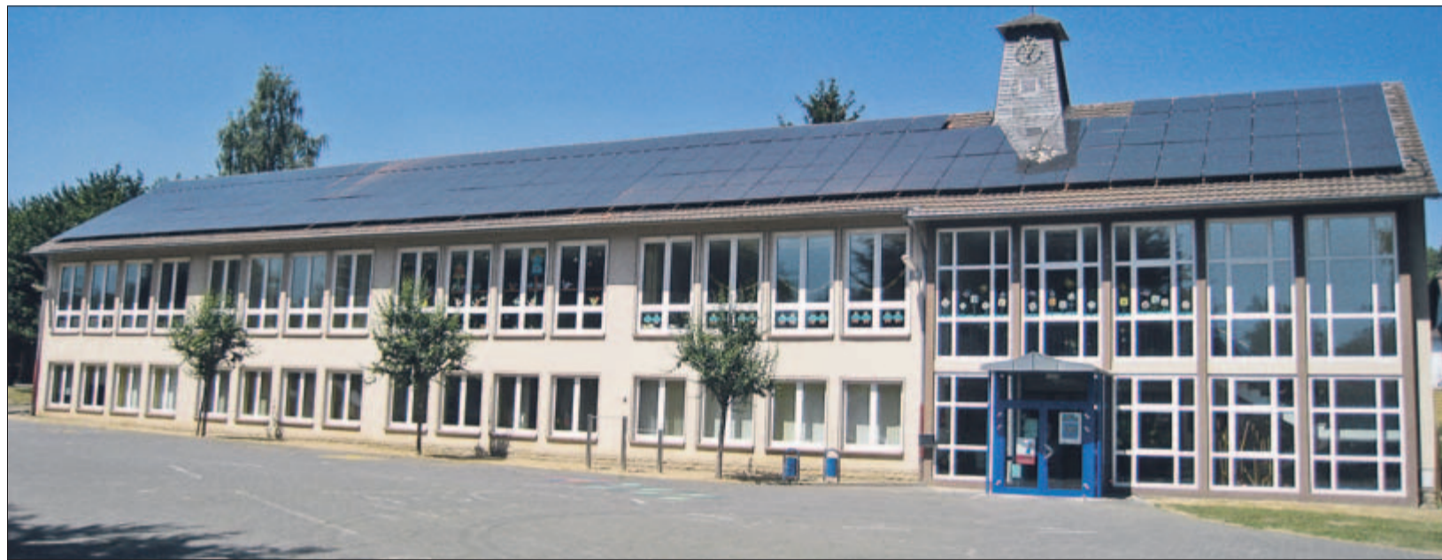
Photovoltaik auf dem Dach: Die Grundschule in Dudeldorf ist eines der bisher realisierten fünf Projekte der Energiegenossenschaft.
