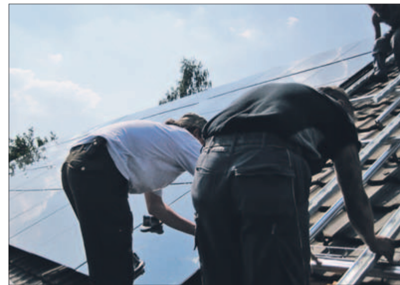
Investitionen aus der Region für die Region: Die Solarmodule werden auf einem Dach installiert. Fotos: Südeifel Strom (2), Bruno Sonnen
