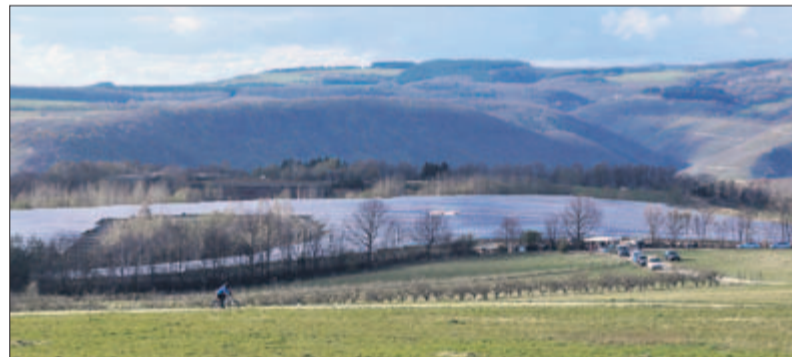
Strom von Bürgern für Bürger: Die neue Photovoltaikanlage bei Neumagen-Dhron ist ein Gemeinschaftsprojekt. Foto: Sandra Blass-Naisar
