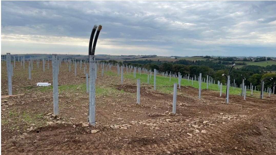
Bis zum Horizont reichen die Stahlpfähle, die als Grundkonstruktion 1,50 tief in den Boden gerammt werden. In Karlshausen beträgt die Fläche des Solarparks 20 bis 30 Hektar, also ungefähr 35 Fußballfelder.
